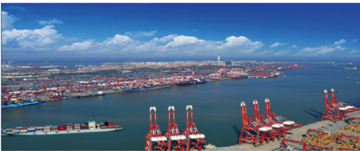
Реконструкция системы горячей воды в порту Циндао, 2016 год.
